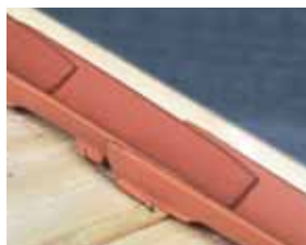
Fixation des tuiles de courant à tenons (Canal Gélis à tenons) en rives latérales gauche et droite par pannetonage.
