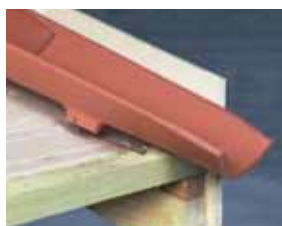
Fixation des tuiles de courant à tenons (Canal Gélis à tenons) du 1 er rang d'égout, en rives latérales gauche et droite par pannetonage.
