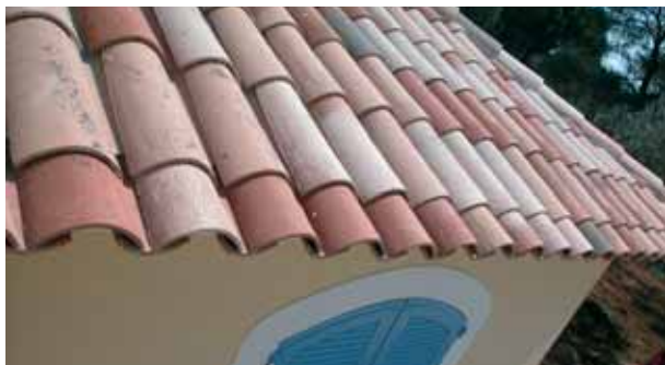
Canal Restauration Gélis Ventoux.
