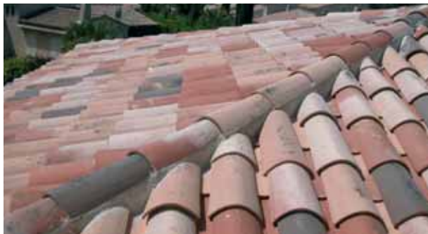
Canal Restauration Gélis Ventoux.
