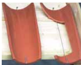
Fixation des tuiles de courant à tenons (Canal Gélis à tenons) du 1 er rang d'égout, en rives latérales gauche et droite par crochets longs à œil Réf. CRCAN.550. La fixation des crochets s'effectue facilement sur le support ou sur les chevrons.
