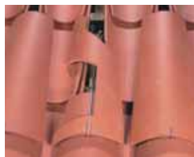
Fixation des tuiles de couvert en plain carré par crochets longs à œil cambré à raison, sur 10 crochets : 2 crochets longs à œil cambré Réf. CRCAN.530.
