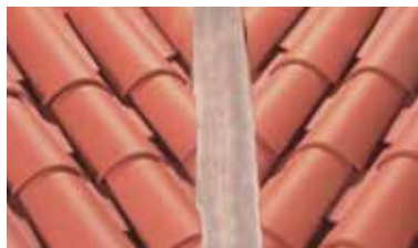
Les tuiles sont tranchées biaisées parallèlement à l'axe de la noue.
