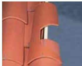
Fixation des tuiles de couvert en rive latérale gauche et droite par crochets «S» à raison de : 1 crochet «S» sur 2 tuiles.
