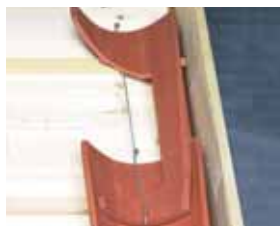
Fixation des tuiles de courant à tenons (Canal Gélis à tenons) en rives latérales gauche et droite par crochets. Réf. CRCAN.550.
