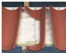
Fixation des tuiles de courant à tenons ( Canal Gélis à tenons ) du 1 er rang d'égout par crochets. Réf. CRCAN.550 La fixation des crochets s'effectue facilement sur le support en égout ou sur les chevrons.
