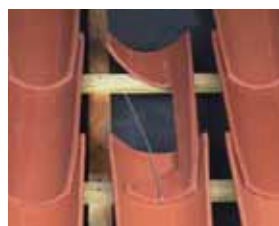
Fixation des tuiles de courant à tenons ( Canal Gélis à tenons ) en plain carré par crochets. Réf. CRCAN.550). La fixation en référence au tableau n° 6 du DTU 40.22 art. 3.334 est assurée par les tenons des tuiles et par les crochets sur les liteaux à raison de : 1 tuile sur 5. La fixation des crochets s'effectue facilement sur les chevrons support des liteaux.
