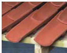
Fixation des tuiles de courant à tenons ( Canal Gélis à tenons ) du 1 er rang d'égout par panne-tonnage.
