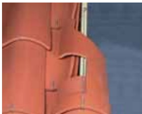
Fixation des tuiles de couvert en rive latérale gauche et droite par crochets longs à œil à raison de : 1 crochet long à œil. Réf. CRCAN.550 sur 2 tuiles.
