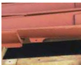
Fixation des tuiles de courant ( Canal Gélis à tenons ) en plain carré par les tenons des tuiles. La fixation en référence au tableau n° 5 du DTU 40.22 art. 3.333 est assurée par les tenons des tuiles.
