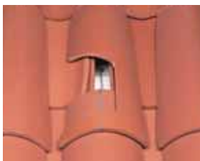
Fixation des tuiles de couvert en plain carré par crochets «S» à raison, sur 10 crochets : 8 crochets «S»
