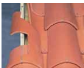
Fixation des tuiles en rives latérales gauche et droite par crochets longs à œil à raison de : 1 crochet long à œil. Réf. CRCAN.550 sur 2 tuiles.
