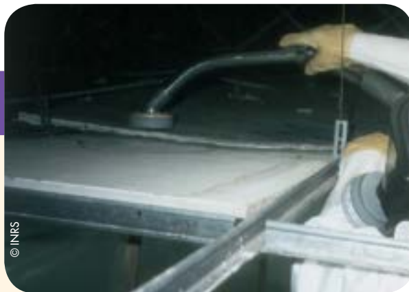
Aspiration à l'aide d'un aspirateur THE, du dessus des dalles de faux-plafond amiantées restées en place
