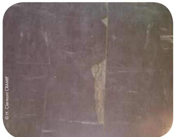
Dalles de sol en vinyle-amiante
