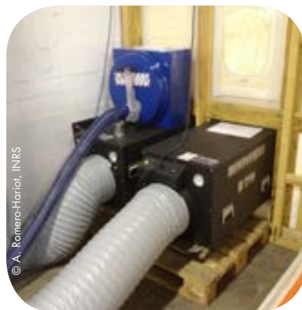
Intervention avec mise en dépression à l'aide d'extracteurs
