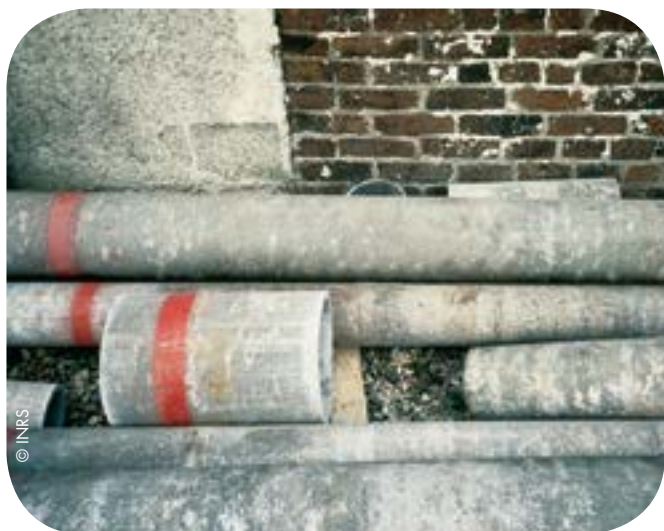
Canalisation en amiante-ciment
