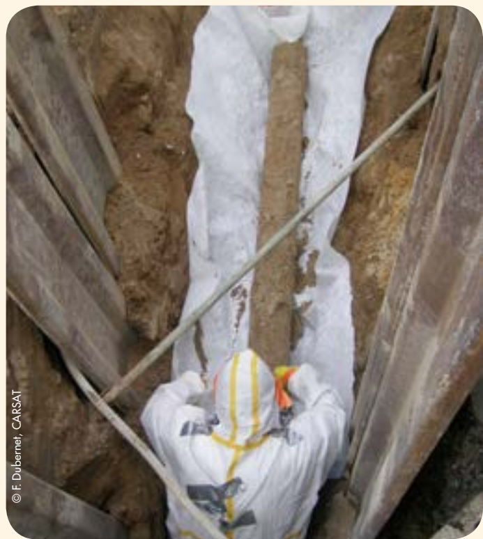
Emballage d'un morceau de canalisation
