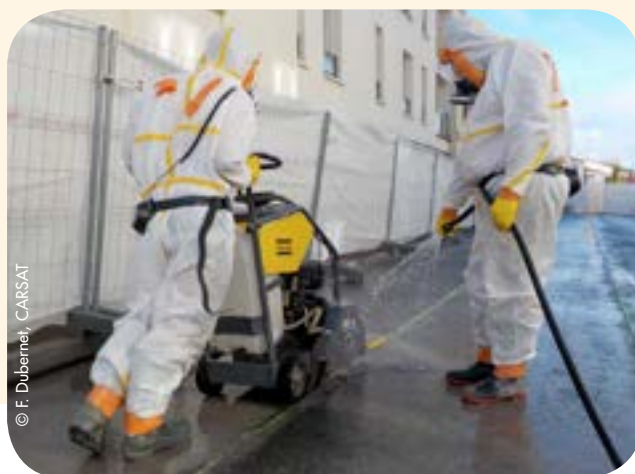
Sciage de chaussée sous arrosage
