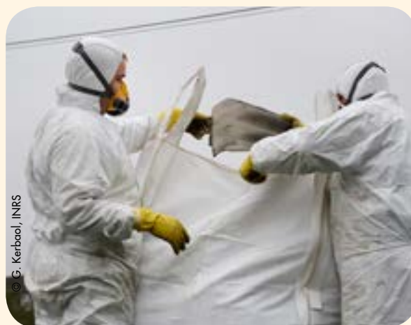
Mise en sac de déchets d'amiante
