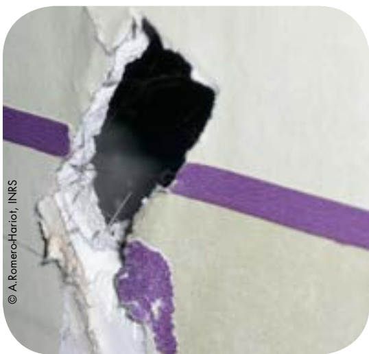
Sondage destructif lors d'un repérage avant travaux
