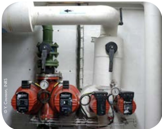
Calorifugeage de conduits
