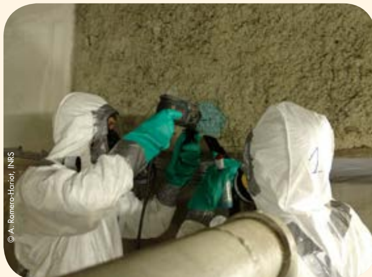
Perçage dans un flochage amianté
