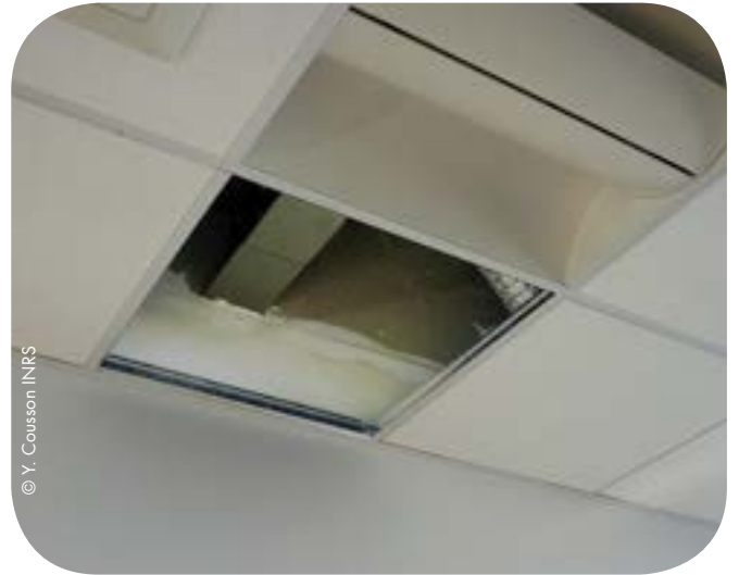
Plaques de faux plafond ignifuge
