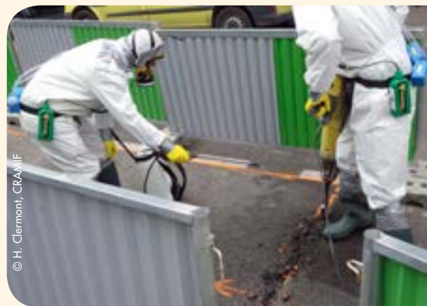
Décroûtage de chaussée au marteau piqueur sous humidification
