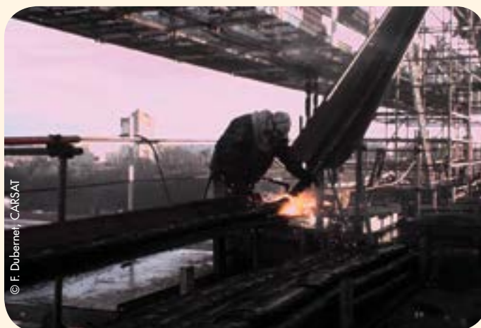
Oxycoupage de câbles amiantés
