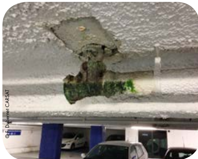
Enduit plâtre chargé à l'amiante
