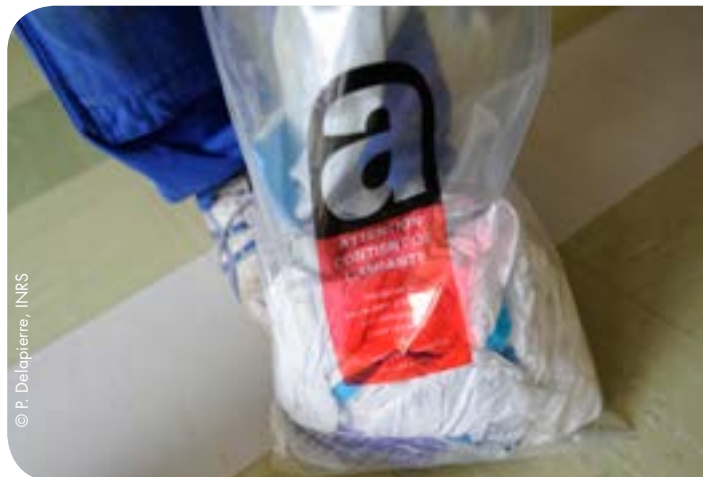
Déchets d'amiante conditionnés
