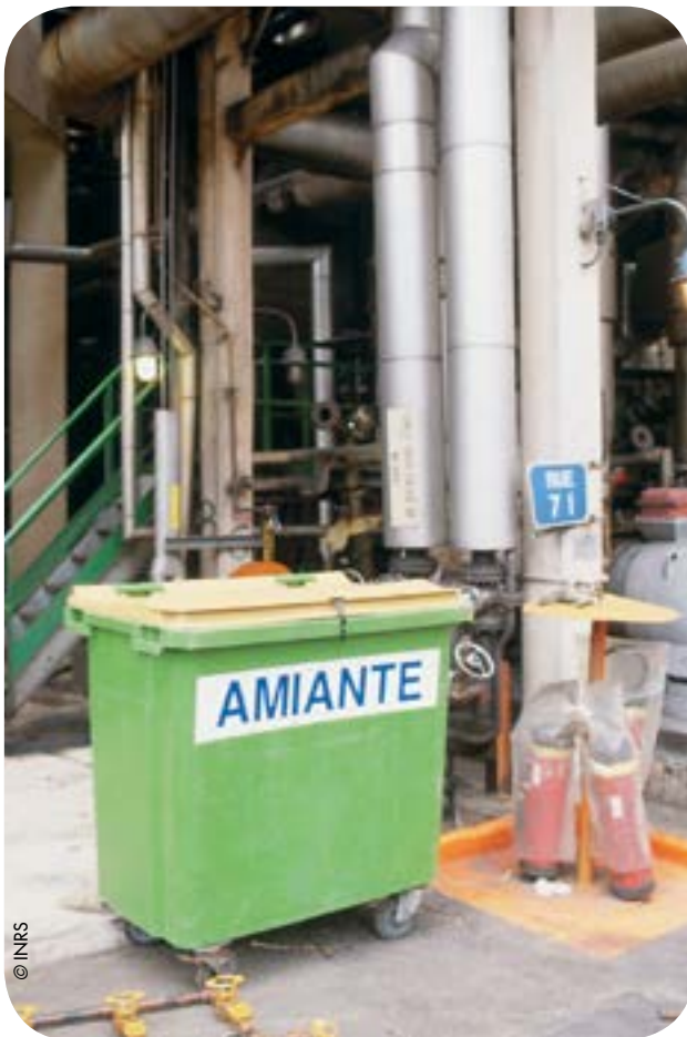
Bac de récupération des déchets sur un chantier de maintenance
