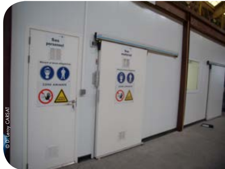
Salle « blanche » pour l'entretien des équipements contaminés
