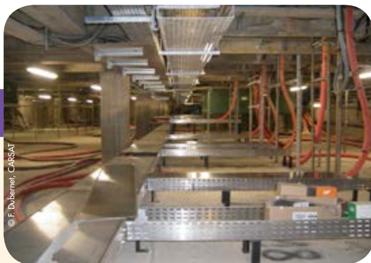
Pose de chemin câble
