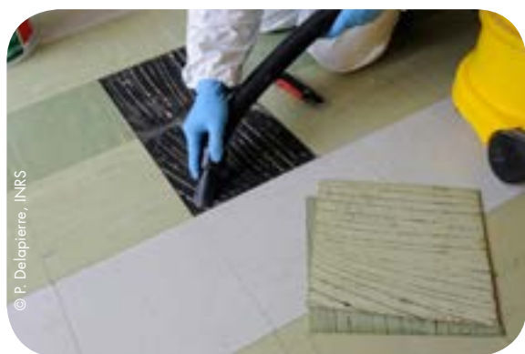
Nettoyage par aspiration avec aspirateur THE
