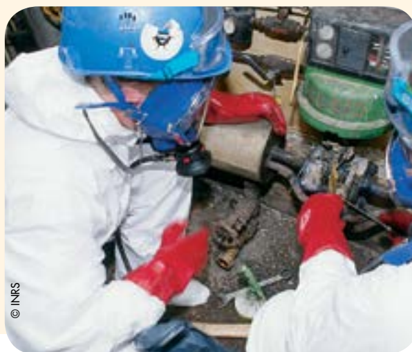
Dégagement de la bande amiantée à l'aide d'un outil manuel
