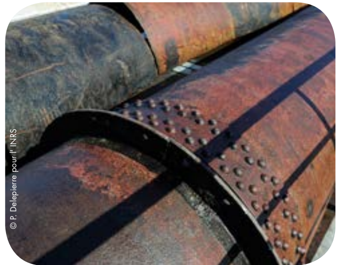
Conduite forcée revêtue de peinture bitumineuse amiantée
