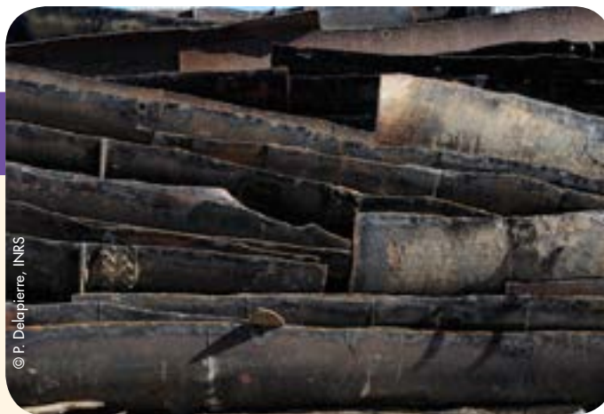
Conduites forcées découpées par oxycoupage
