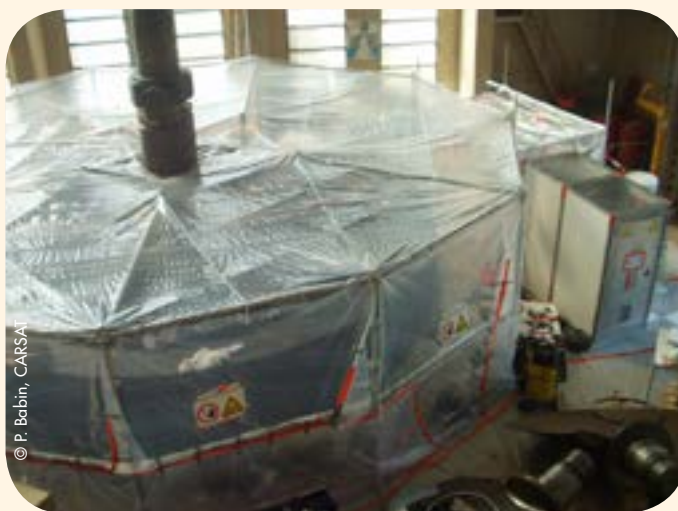
Confinement du rotor avec installation de décontamination
